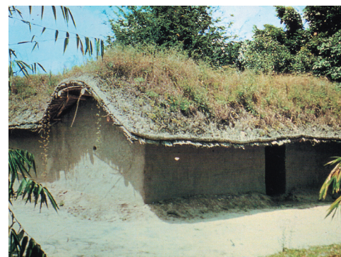
Abb. 11: Grasgedecktes Haus in Tansania
